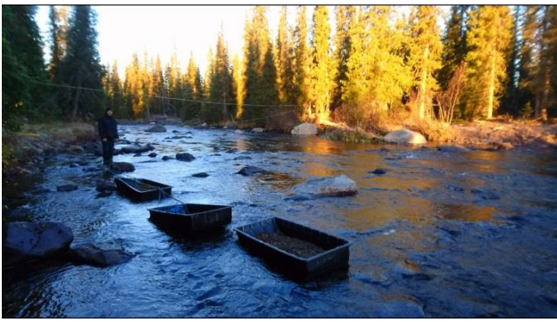
Bild 2. Lekgrus transporteras upp på lekområden i Marsån mha vinsch och pulkor. Foto: Magnus Lindberg, Länsstyrelsen Västerbotten.
