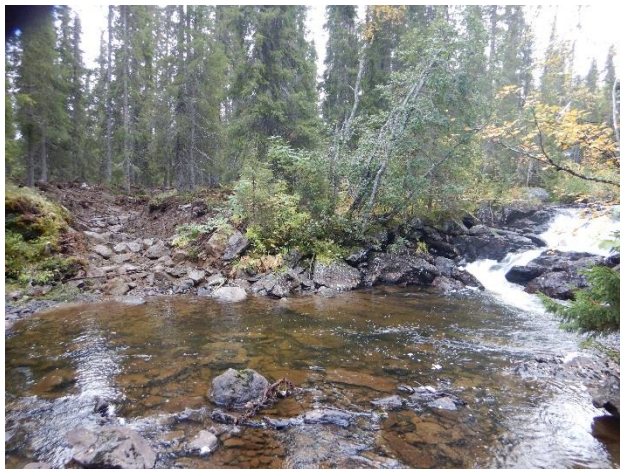
Bild 4. Omlöpet i Gäddbäcken. Till höger syns det vandringshinderande vattenfallet och till vänster den nygrävda bäckfåran innan vattnet släpptes på. Nu ska öringen åter kunna simma fritt på denna del av bäcken. Foto: Magnus Lindberg, Länsstyrelsen Västerbotten.
